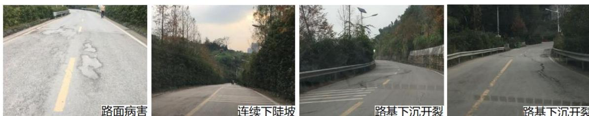
②凤凰山北路（路基宽度 6m）：起于巴人文化广场止于一碗水岔路口，路线全长 1.942km。道路平面局部不满足要求；纵断面局部大纵坡坡长超限，局部缺少缓坡；现状道路路基 6.0 米，路基局部开裂下沉；现状路面 6.0 米，路面为砼路面且破损严重。
